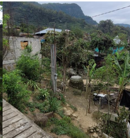
Fotografía 48. La localidad de Toctitlán se encuentra asentada en una ladera, y no cuenta con infraestructura para evitar que el escurrimiento de agua y material de arrastre.
