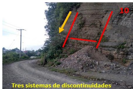
Fotografía 19. Corte del talud labrado en una secuencia de arenisca, lutita con monte, compuesto por bloques planos de falla paralelo al corte del subredondeados en una matriz arcillo-talud, lo que lo hace susceptible a caída arenosa de bloques.
