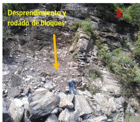
Fotografía 18. Desprendimiento y rodado de bloques, zona de pliegues y fracturas.
