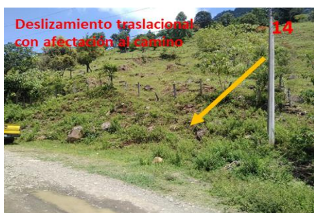
Fotografía 5. Deslizamientos traslacionales afectando camino Tlahuetongo-Tecontla.
