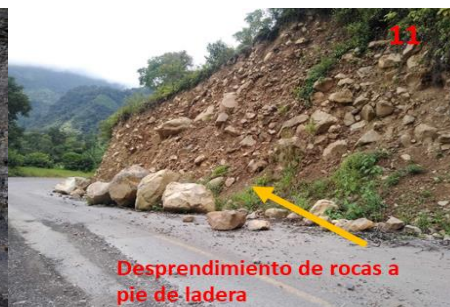
Fotografía 19. Corte del talud labrado en una secuencia de arenisca, lutita con monte, compuesto por bloques planos de falla paralelo al corte del subredondeados en una matriz arcillo-talud, lo que lo hace susceptible a caída arenosa de bloques.
