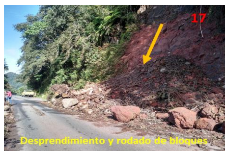
Fotografía 26. Caída de bloques por efecto de erosión diferencial entre la toba y andesita-basalto.
