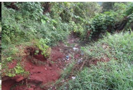
Fotografía 45. Erosión de material causado por los flujos de origen pluvial en la localidad de Tierra Colorada, municipio de Tlanchinol..
