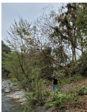
Fotografía 50. Acuapa, bordo con 6 metros de altura.
