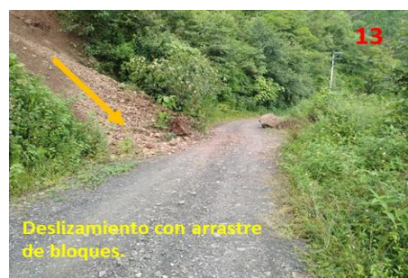
Fotografía 4. Deslizamiento traslacional con arrastre de bloques
