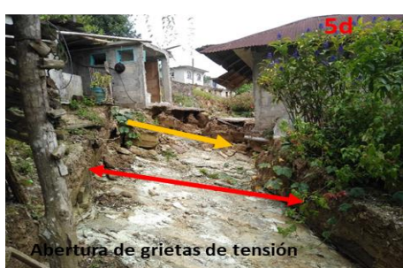
Fotografía 12. Deslizamientos con grietas que tienen aberturas de más de 2 metros.
