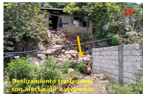
Fotografía 8. Deslizamiento traslacional con afectación a una vivienda en la localidad de Ehuatitla.
